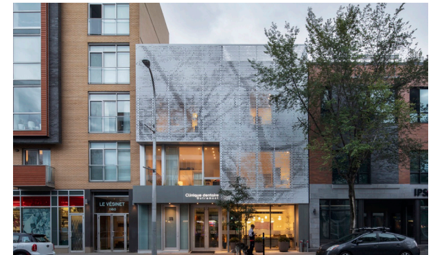
Traitement des rez-de-chaussées en interaction avec le domaine public, Montréal
