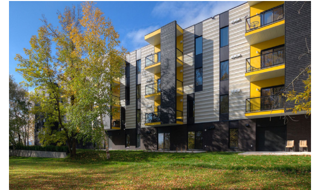
Verdissement des cours arrière, Beauport
