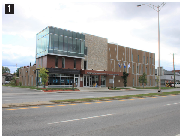
Bureaux de la MRC de Vaudreuil-Soulanges, de Développement Vaudreuil-Soulanges et de la cour régionale municipale Source : Provencher_Roy, 2019
