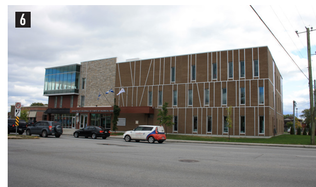
6 Bureaux de la MRC, DEV, la cour régionale municipale et l'ORHVS Source : Provencher_Roy, 2019
