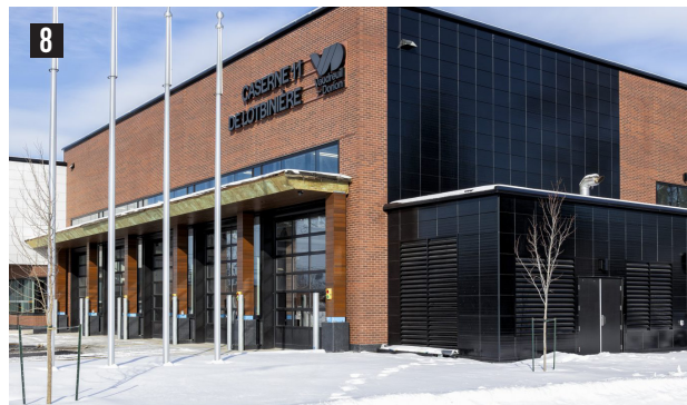
8 Caserne de pompiers no 11 Source : Christian Gonzalez
