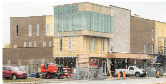
Construction du pôle civique régional Source : Josianne Farand, INFO Suroît, 2016
