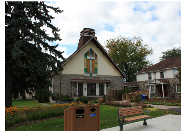
Opticentre Saint-Jean-Baptiste Source : Provencher_Roy, 2019
