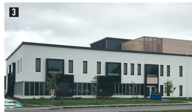
3 Bâtiment du centre de formation aux adultes Source : Centre de services scolaire des Trois-Lacs
