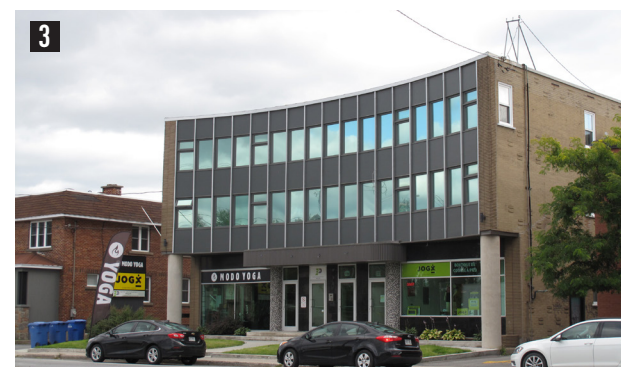
3 Conversion commerciale d'une ancienne succursale de la Banque Nationale du Canada, boulevard Harwood
