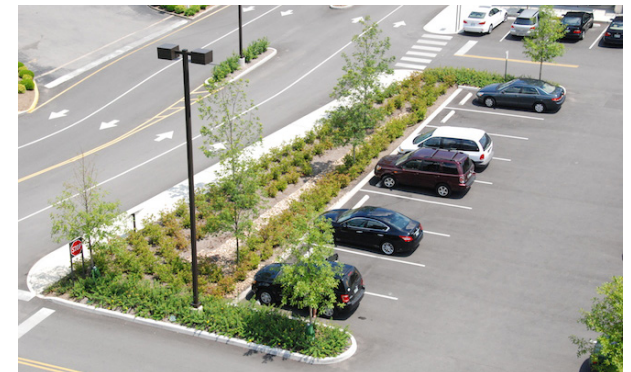
Inclusion de zones de verdissement et des mesures de gestion des eaux pluviales à l'aire de stationnement extérieure
